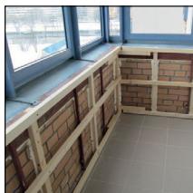
Крепление направляющих для лёгких конструкций
