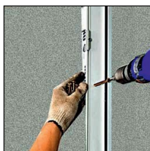
Крепление дверных рам к различным видам оснований
